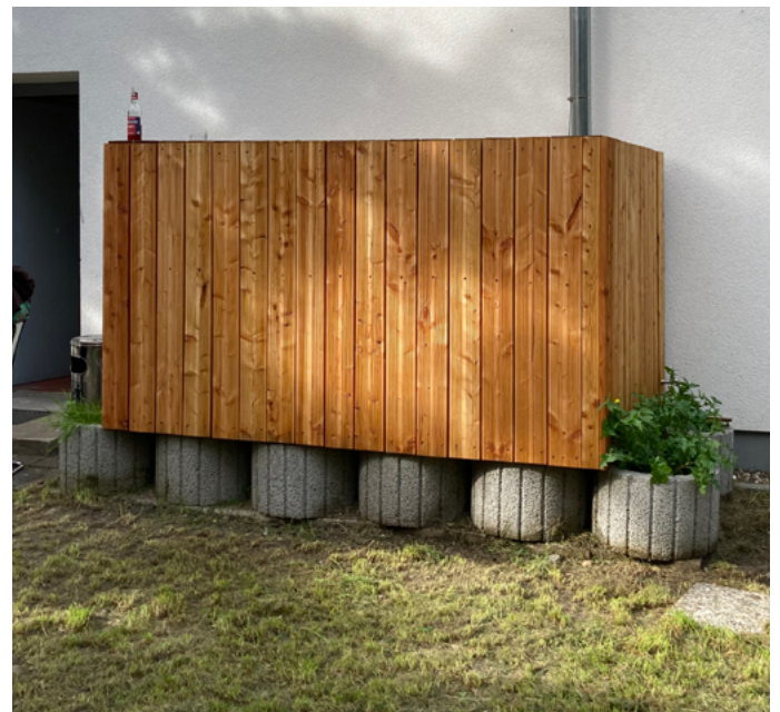
© iResilience: Realisierte Wasser-Tanke AWO Bunker Dortmund
